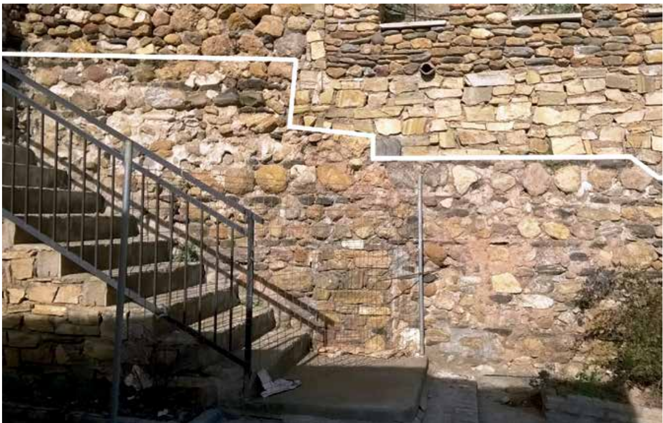
Restos de los paramentos de mampostería antigua trabada con yeso a base de fajas separadas por lajas de esquisto en la base del muro entre las dos torres de la zona este.
