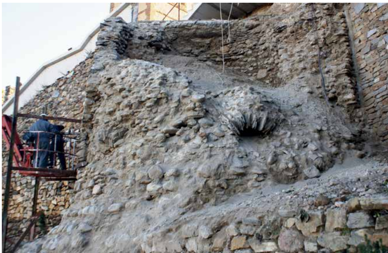
Interior de la torre tras la limpieza inicial donde se ve la cara interna del piso superior y la zona intermedia con los arcos de pizarra de las posibles saeteras.
