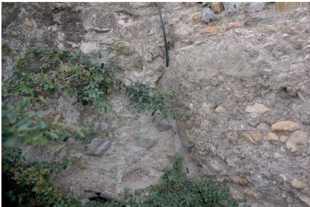
Restos de los encofrados medievales en la base de la torre mayor de la zona este.
