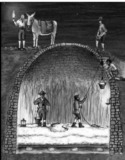
Dibujo de los trabajos realizados en los pozos de nieve. Archivo Comarca del Somontano de Barbastro
